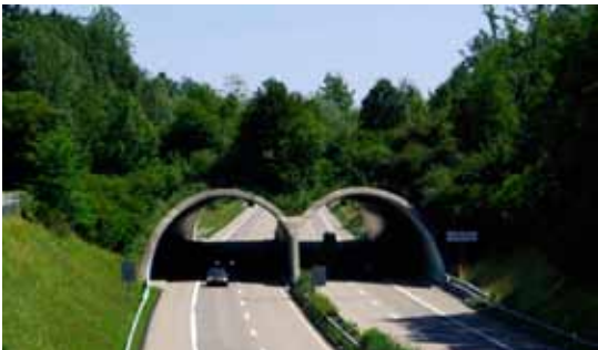
ABAJO Paso elevado de Wigoltingen sobre la carretera A-7 en Thurgau, Suiza, de 140 metros de longitud, construido en 1992. Foto: Carlos Iglesias M.
