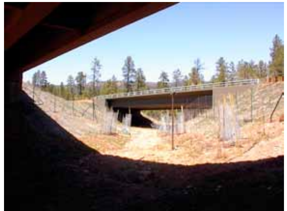
Pasos de vida silvestre “viaductos” en Arizona
